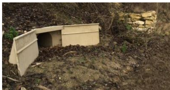
Exemple de passage à faune souterrain – Source : IASEF
