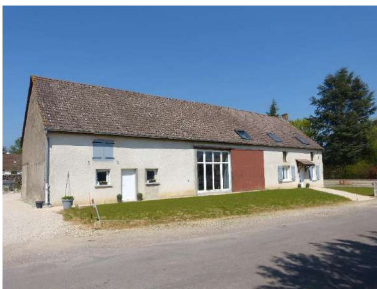
Une ferme en bloc en rénovation
