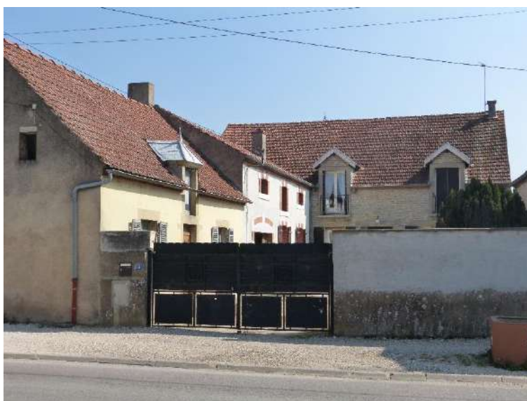
Les rares murs hauts se situent dans le centre ancien
