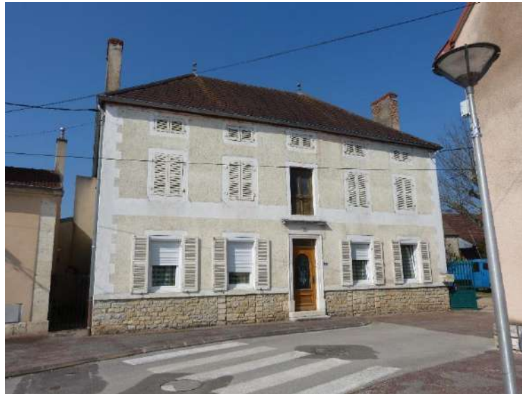
Un immeuble ancien près du groupe scolaire
